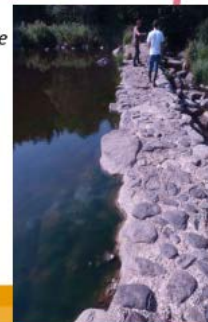
Levée en travers du Lignon (difficilement franchissable / génère une retenue de près de 200 m / perturbation de la dynamique sédimentaire / eutrophisation et perte d'habitats)
