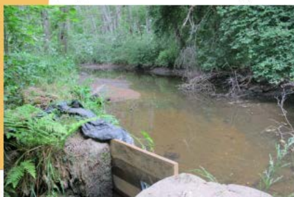
Seuil connexion bief vers bras de décharge et Lignon (infranchissable / génère zone lenticule envasée / perturbation de la dévalaison de glochidies)
