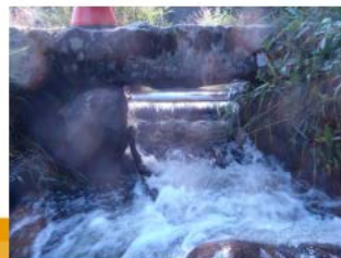
Levée en travers du Lignon (difficilement franchissable / génère une retenue de près de 200 m / perturbation de la dynamique sédimentaire / eutrophisation et perte d'habitats)
